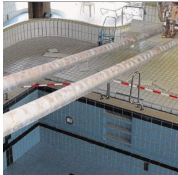
Das Becken im Hallenbad bleibt leer. In Tirschenreuth sind Korrosionsschäden an den Zugseilen der Decke schuld. Bild: hfz
