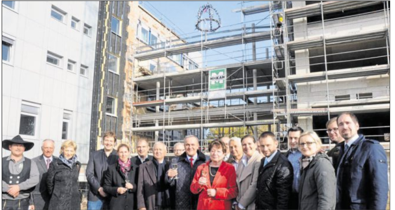
Ganz schön Druck macht auch das Medienhaus „Der neue Tag“ bei seinen Bautätigkeiten. Der Grundsteinlegung im Mai folgte Ende Oktober schon das Richtfest für den Neubau an der Dr.-Pfleger-Straße. Im Herbst 2016 soll er bezogen sein. Schon im Frühjahr wollen Geschäftsstelle und Ticketverkauf in das 40 Jahre alte generalsanierte Verlagsgebäude an der Weigelstraße zurückkehren. Nur fünf Jahre nach dem Bau des Druckzentrums in Weiden-West investiert der Verlag erneut kräftig (11 Millionen Euro) und legt ein klares Bekenntnis zum Standort Weiden ab.
