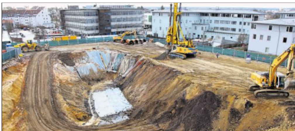
Ambergs größte Grube entsteht durch die Altlasten-Entsorgung auf dem ehemaligen Baumann-Gelände: Insgesamt müssen 75 000 Tonnen Erdrich abtransportiert werden. Bild: Huber
