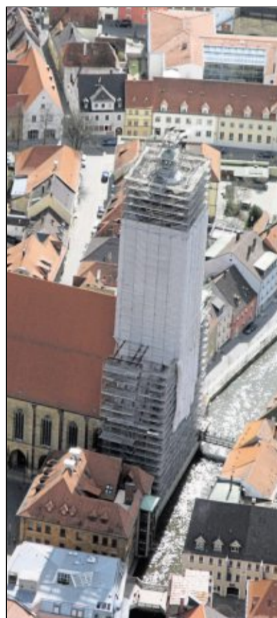
Die Sanierung des Martinsturms wird viele Hunderttausend Euro teurer als die vor längerer Zeit geschätzten 550 000 Euro: Inzwischen muss von 1,1 Millionen Euro ausgegangen werden – denn die Schäden sind sehr viel größer als vermutet. Der eingerüstete Turm wird ein Bild des Jahres. Bild: Bernd Georgi
