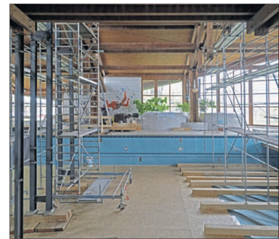
Für die nächsten fünf, sechs Jahre gesichert ist der Betrieb des Tirschenreuther Hallenbads. Der Austausch der maroden Stahlaufhängung des Daches hat eine Viertelmillion Euro gekostet. Auf lange Sicht steht eine Generalsanierung oder ein Neubau bevor. Bild: tr
