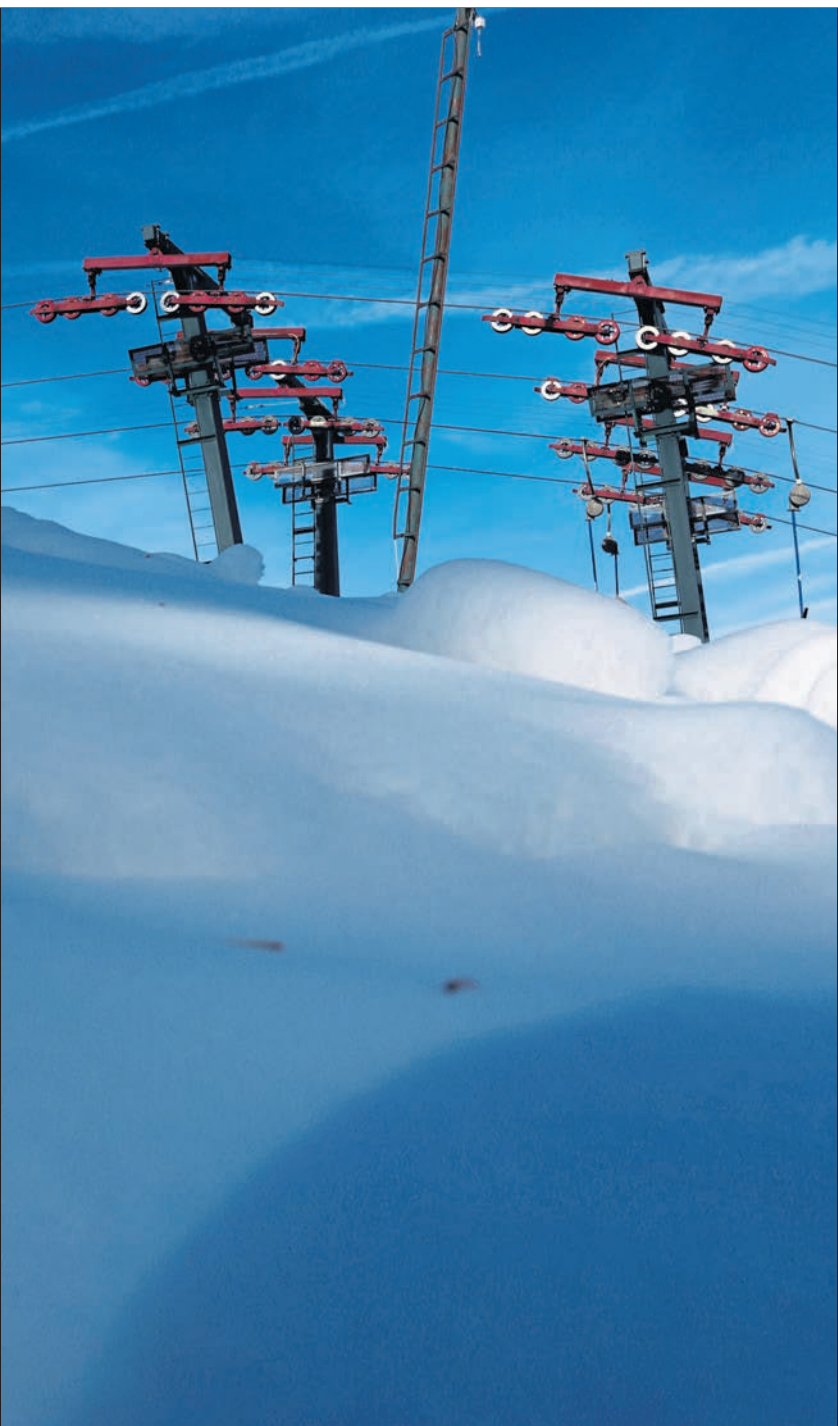
Stützen eines Schleppliftes im Skigebiet Grasgehren am Riedberger Horn bei Obermaiselstein (Oberallgäu). Bild: dpa
