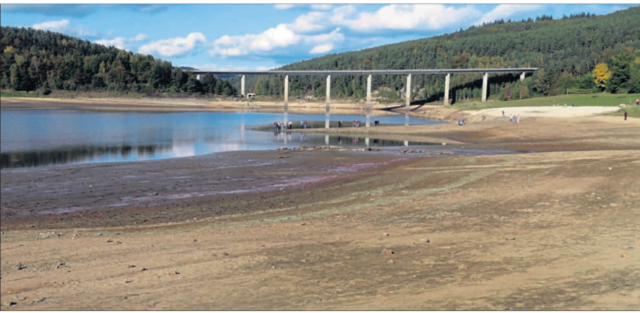
Wegen einer Überprüfung der technischen Anlagen wird der Eixendorfer Stausee ab 13. September um rund fünf Meter abgesenkt. Durch die „Ebbe“ tauchen Reste alter Straßen, Fundamente ehemaliger Brücken und Überbleibsel der alten Eisenbahnlinie auf und locken zahlreiche Besucher an. Fischereiverbände üben Kritik an der Absenkung und befürchten Auswirkungen auf die Ökologie des Gewässers. Bild: Götz
